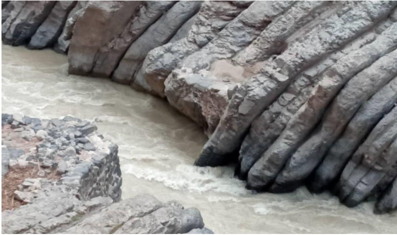
تصویر (۱۶): پل یک‌دهنه جهت عبور به روستای نزدیکی پل کول (همان)
