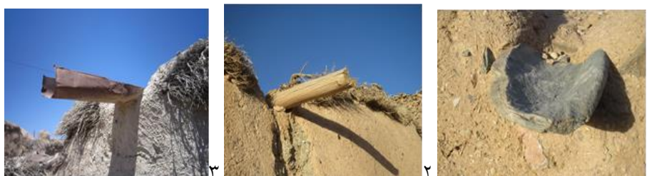
تصویر ۴: سیر تحول ناودان: ۱- ناودان سنگی ۲- ناودان چوبی ۳- ناودان آهنی (نگارنده: ۱۳۹۴)
