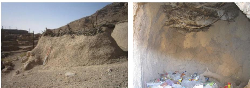
تصویر ۱۴: شکل‌گیری سازه براساس چوب سقف در داخل و بیرون، در ماخونیک (نگارنده، ۱۳۹۵)
