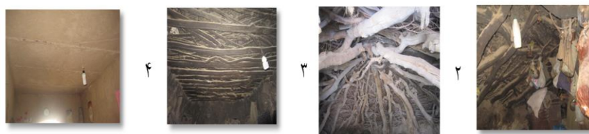
تصویر ۶: ۱- سقف هشتی شکل در بافت سنتی ۲- سقف مرکزگرا در بافت سنتی ۳- سقف مسطح در بافت درحال‌گذار ۴- سقف آهنی در بافت جدید (نگارنده، ۱۳۹۴)
